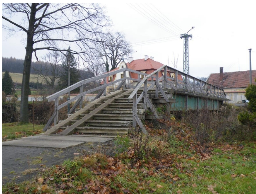
Provizorní lávka nedaleko kostela
