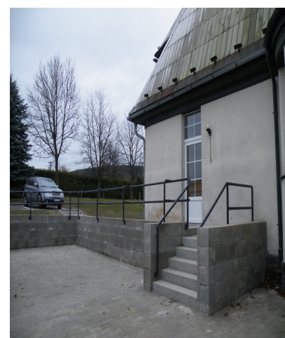
Nové schody do střediska
