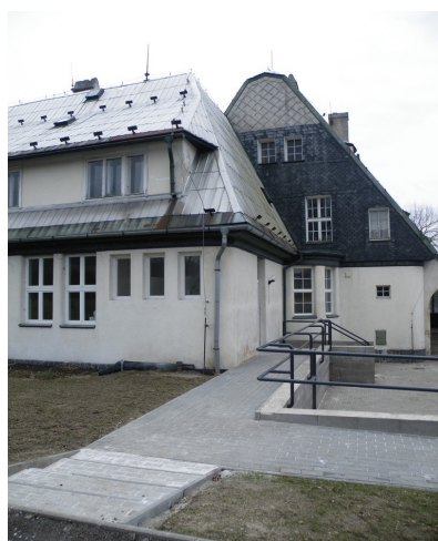
Bezbariérový přístup do střediska
