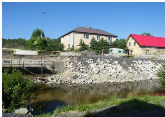
Fučíkova ul. - oprava břehové zdi "U Malíře"
