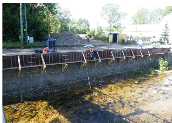
Oprava břehové zdi u "sběrných surovin"
