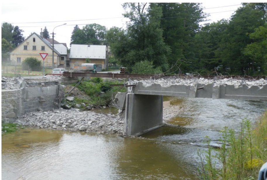
Demolice mostu u mlýna 10. 7. 2013
